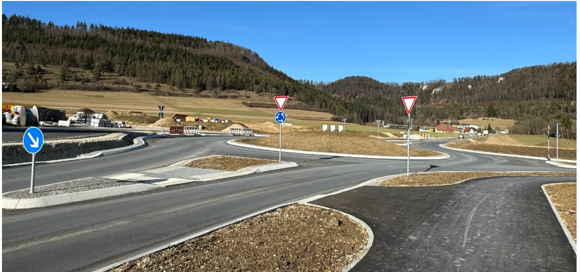
Plangebiet – Blick von der Kolbinger Straße mit neuem Kreisverkehr nach Osten Stand 02/2024
