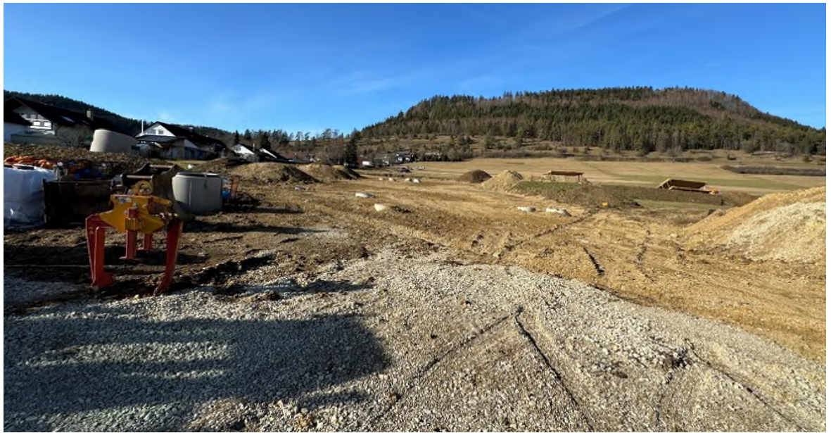
Erschließungsmaßnahmen im Plangebiet Stand 02/2024
