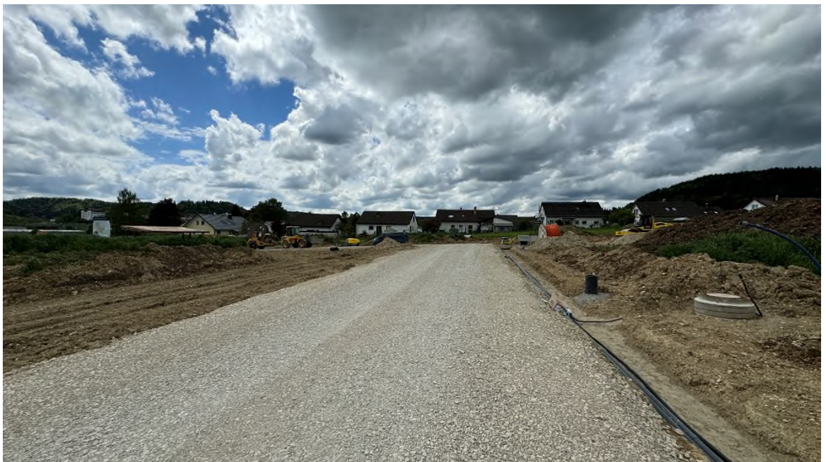
Plangebiet – Blick nach Westen von der Schwalbenstraße Stand 05/2024
