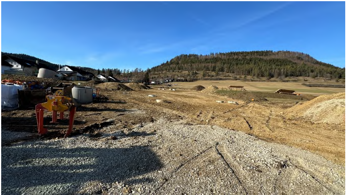
Aktuelle Erschließungsmaßnahmen im Plangebiet Stand 02/2024
