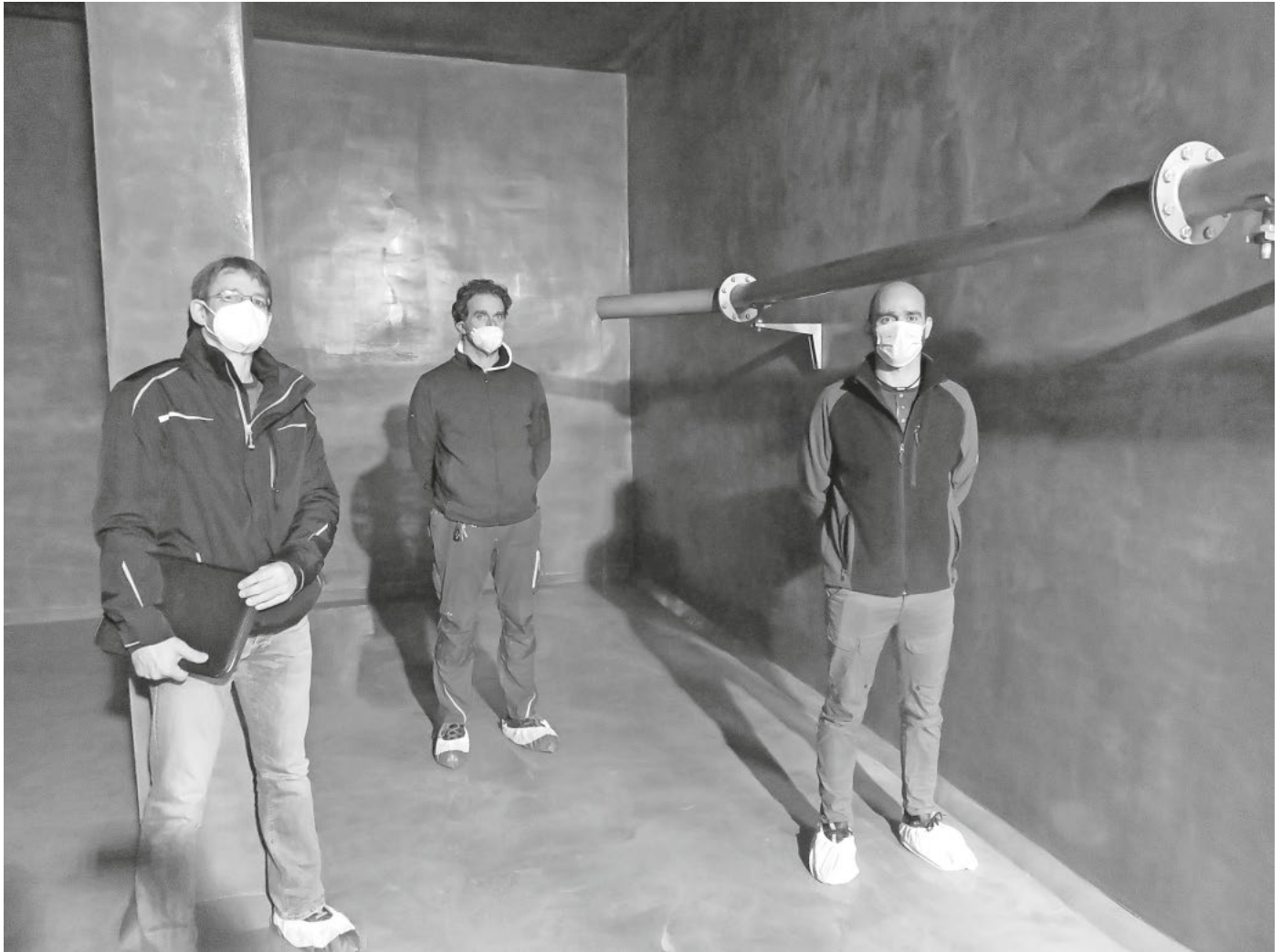
Planer und Bauleiter Thomas Gierth, IMS Ingenieure, Wassermeister René Kantwerk und Denis Gantert von der bauausführenden Firma Orth & Schöpflin freuen sich über die gelungene Sanierung (von links).
